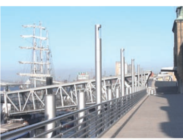
Stahlbau an den Landungsbrücken
