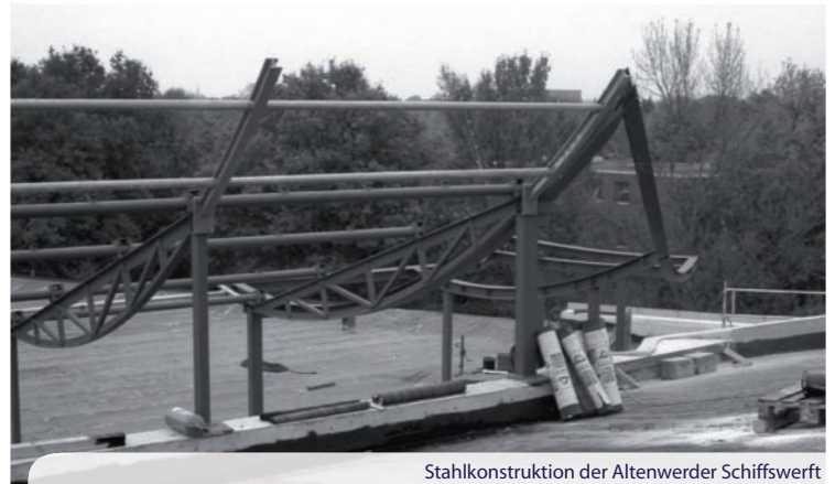
Stahlkonstruktion der Altenwerder Schiffswerft
